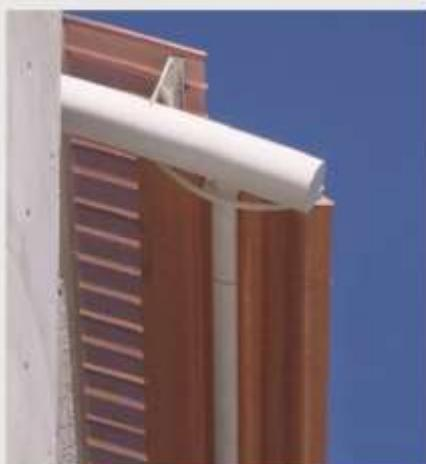
El Cortasol Termobrise es un producto diseñado para fachadas de edificios, como protector de la incidencia de los rayos solares y del ruido externo. Las paletas se pueden instalar en forma vertical u horizontal según el diseño. Debido al bajo peso de sus componentes el cortasol Termobrise puede adosarse a cualquier tipo de estructura con una mínima sobrecarga, permitiendo su uso tanto en obras nuevas como en remodelaciones.
