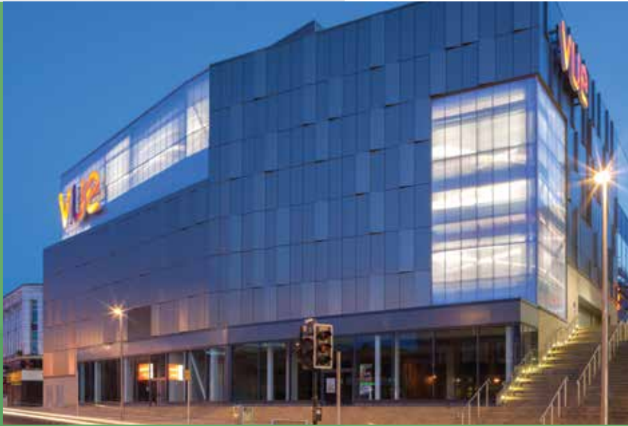
Cine Vue, Gateshead; Francia | Sistema de Fachada sencilla en Danpal® de 22mm | Arquitecto: 3D Reid
